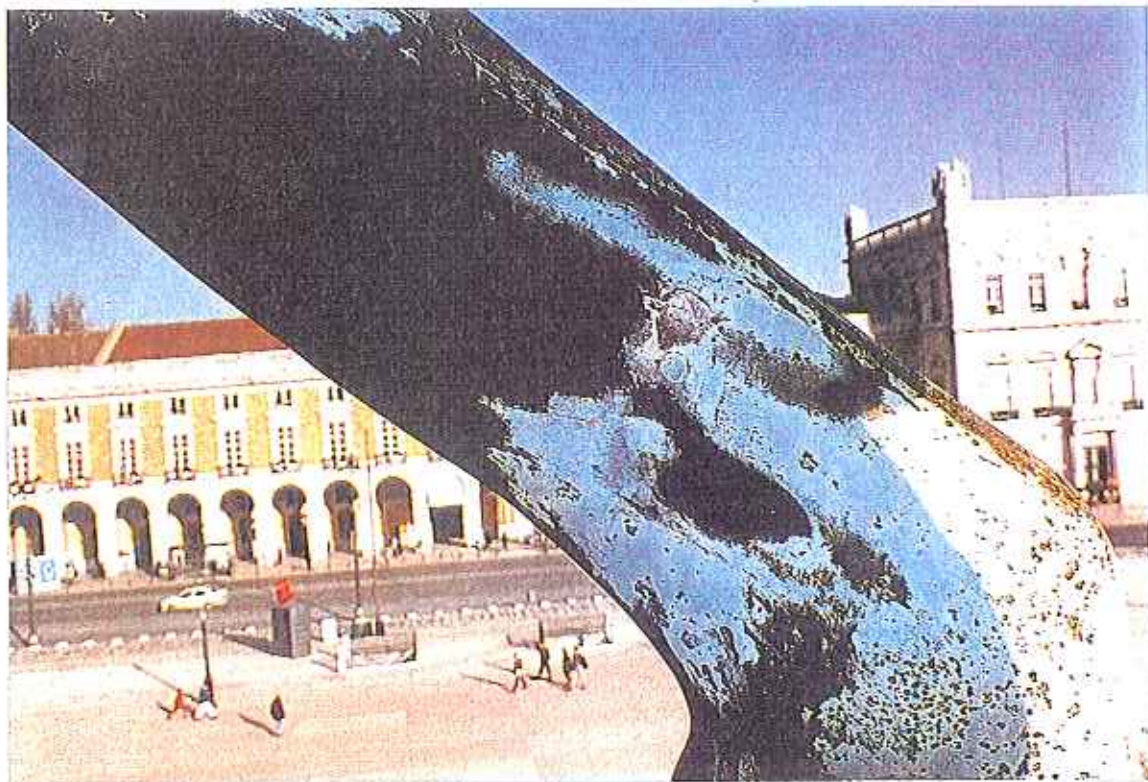
Fig.A22 – Estátua de D. José I. Zona da liga com um enchimento esbranquiçado.
