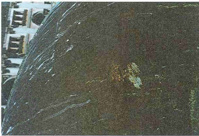
Fig. 14 - Patina verde sob a pelúcula castanha-ferruginosa e escorrimentos provocados pelos dejectos dos pombos.
