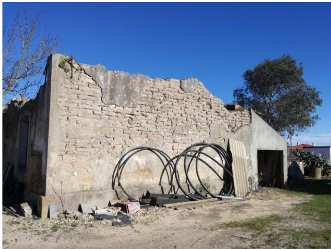
Preenchimento com pedra até 1,20m
