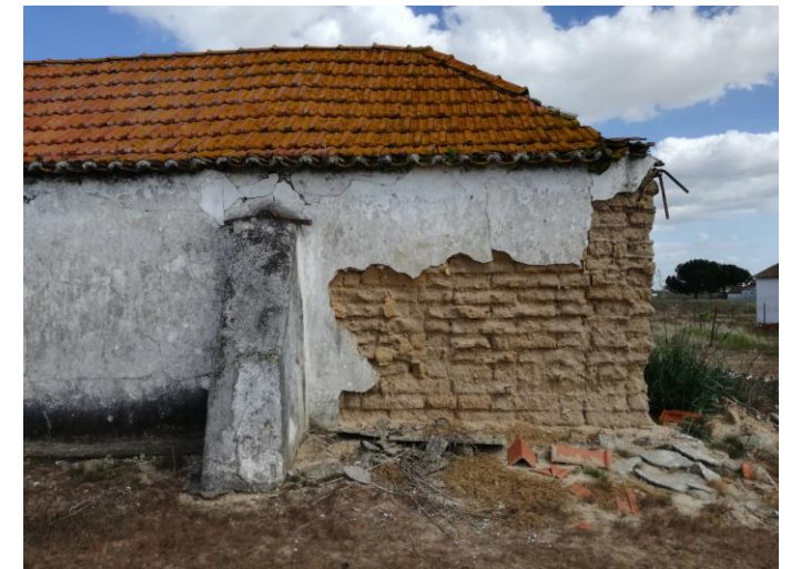
Preenchimento com adobes
