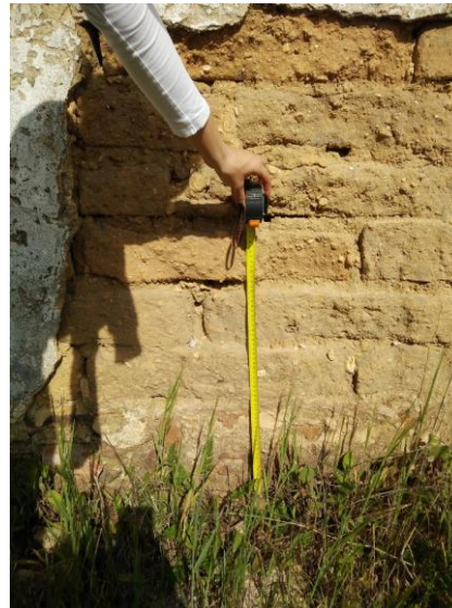
Preenchimento com pedra até 0,60 m
